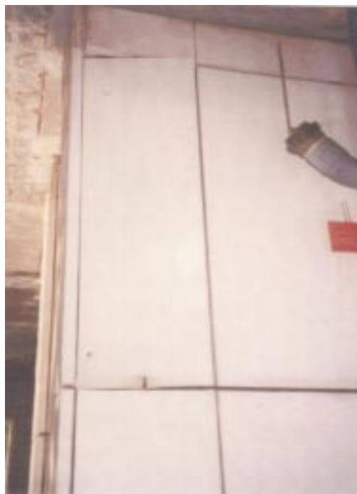
Figure 17 – Éclat aux agrafes et pivotement dû à l'insuffisance d'attache
