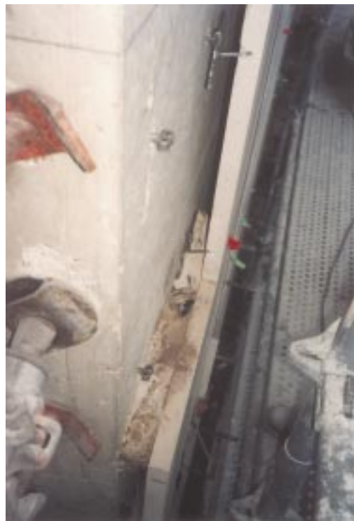
Figure 19 – Polochon continu créant un défaut de ventilation de la lame d'air
